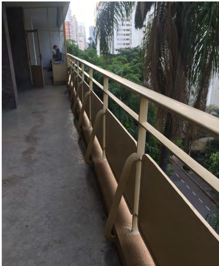
pré-existência: esquadrias de ferro amarelas
